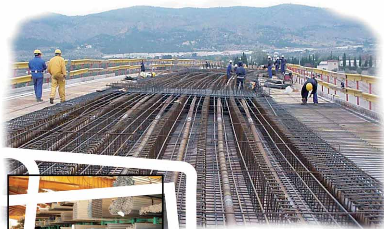
AUTOVÍA SAN CASTELA — OBRA REALIZADA POR HIERROS DEL NOROESTE
