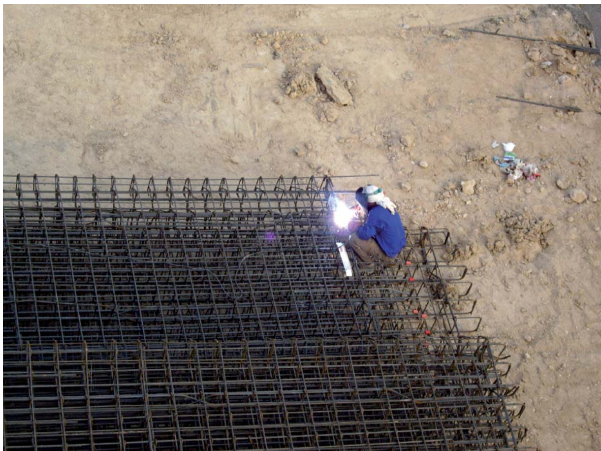
📷 Fotografía 1.- Soldadura en obra.
