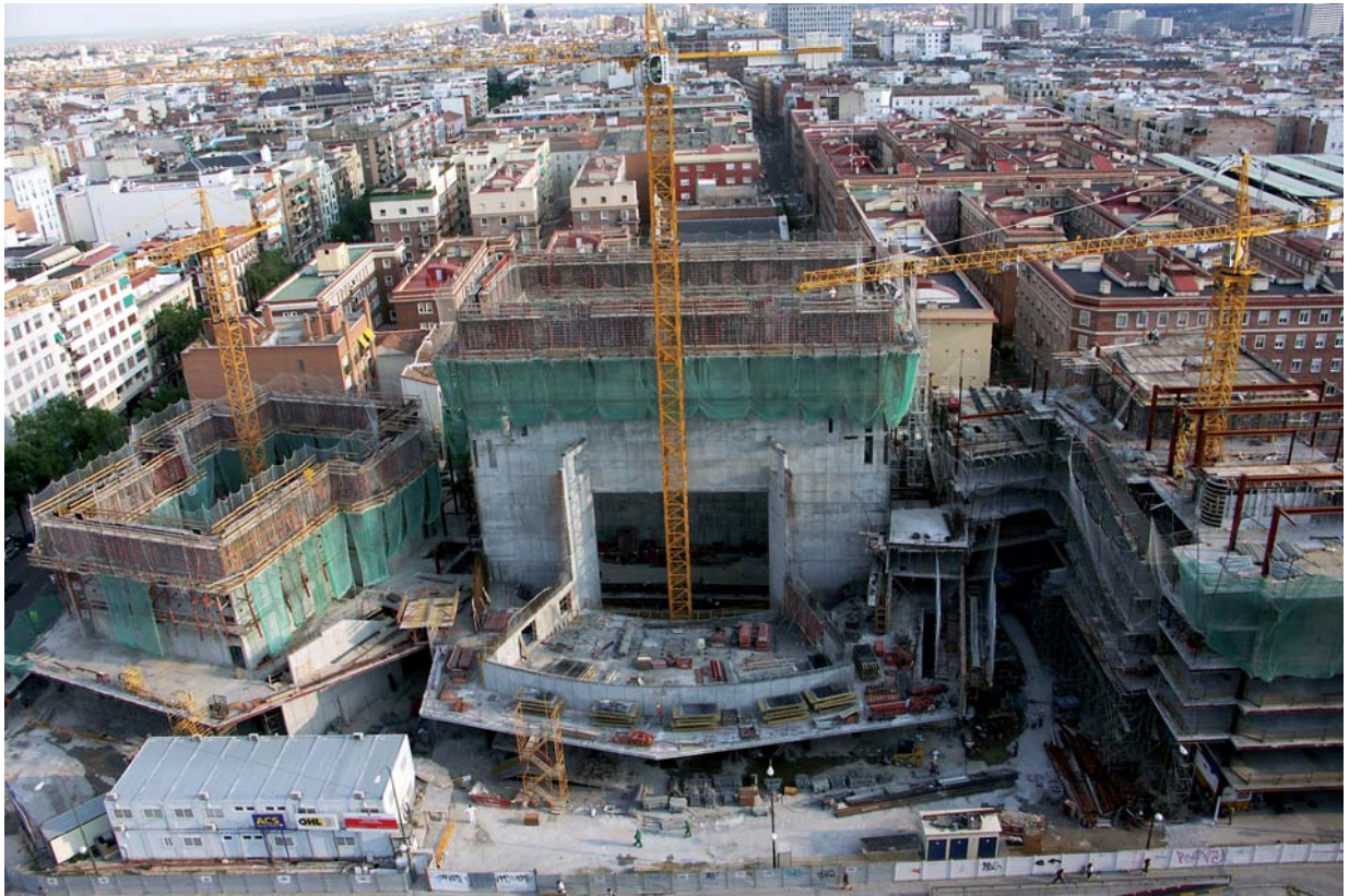
Figura 12 - Cajas escénicas en ejecución.
