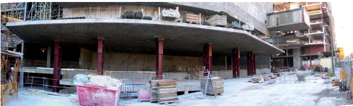
Figura 10 - Teatro Principal. Losa en voladizo sobre apeos.
