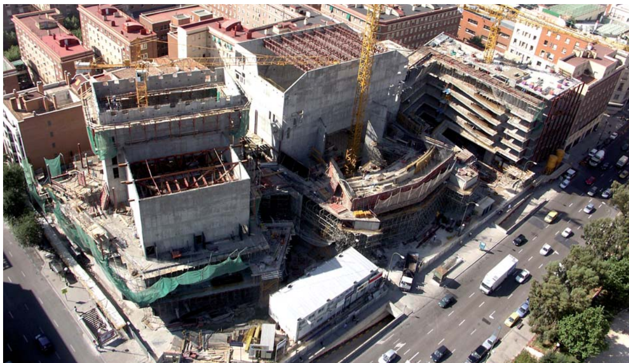
Figura 13 - Cajas escénicas prácticamente terminadas. Cuerpos frontales en ejecución.
