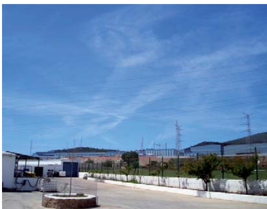
➔ Instalaciones de depuración de agua en la nueva acería.
