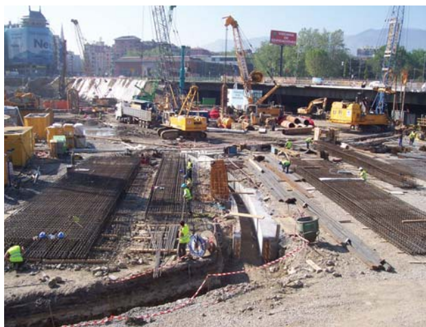
Figura 4.- Montaje de la armadura de los módulos de muro pantalla (Fuente: Torre Iberdrola).
