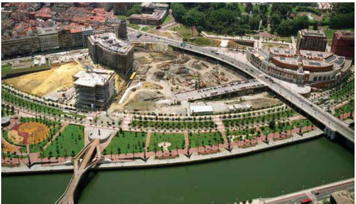
Figura 3.- Estado de la parcela al inicio de las obras (Fuente: Torre Iberdrola).
