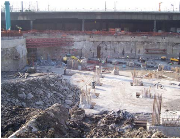
Figura 5.- Cimentación profunda (Fuente: Torre Iberdrola).
