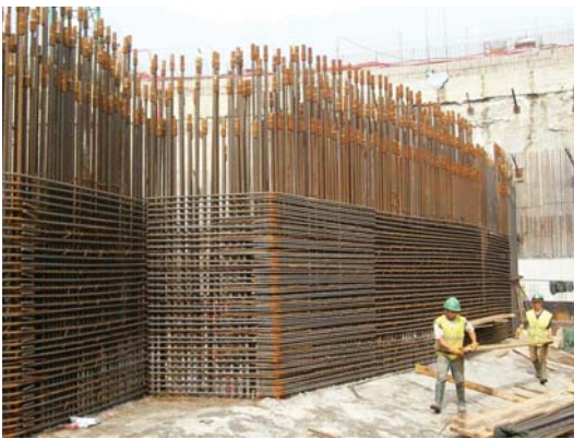
Figura 9.- Detalle de la densidad de armadura que requirió el empleo de empalmes mecánicos (Fuente: Torre Iberdrola).
