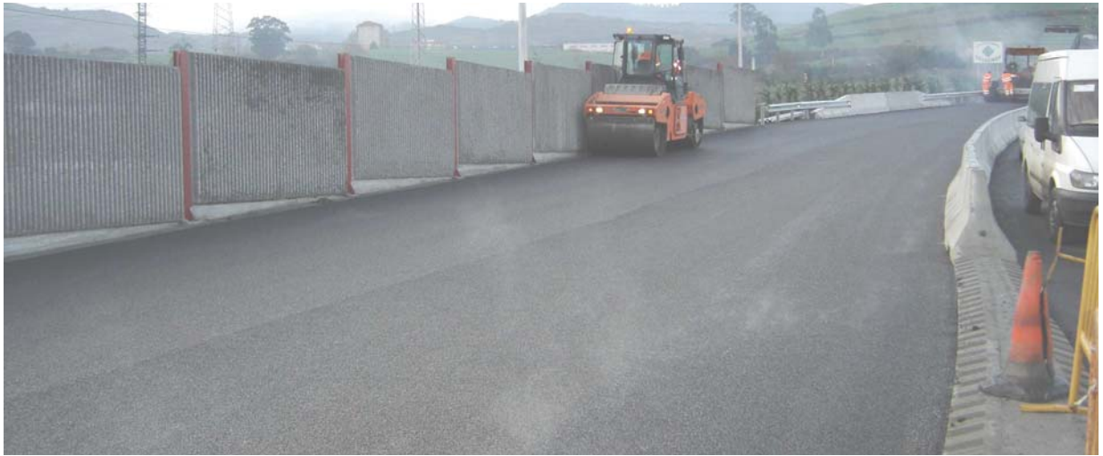
Figura 6.- Rodadura bituminosa con escoria como árido (Foto cortesía de ACYMA).
