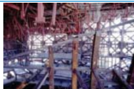
Gráfico 2- La complejidad interna de la obra en construcción
