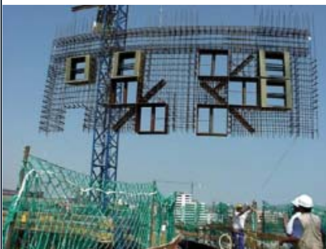
Izado con balancín de un panel.
