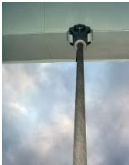
Detalles del puente de Nájera.
