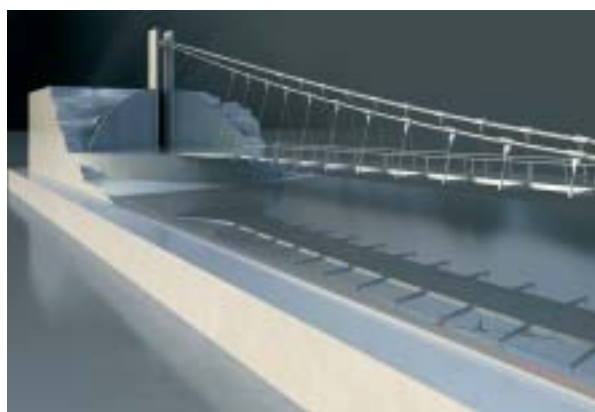
Imagen de la integración del ascensor-montacargas en la pasarela sobre el río Tajo en Toledo.
