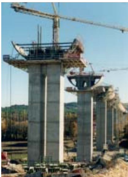
Técnica de voladizo.
