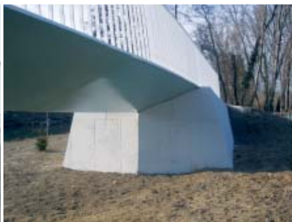
Detalles pasarela de Palencia.
