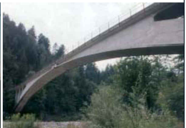
Puente de Rossgraben (Suiza).
