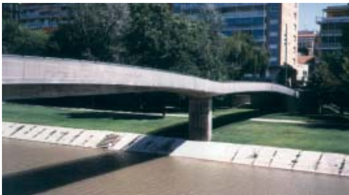
Pasarela sobre el río Segre. Balaguer (Lérida).
