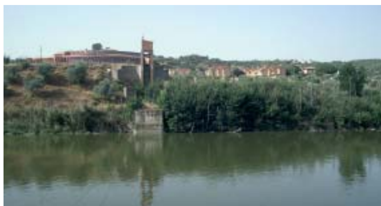
Vista del ascensor-montacargas a recuperar en la pasarela sobre el río Tajo.
